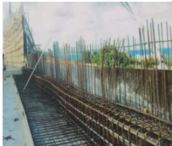
Saadiyyat Project – Pouring wall
