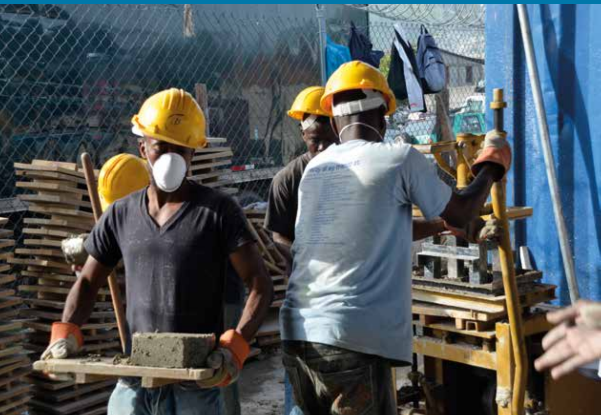
Trabajadores de la construcción ayudando a reconstruir Haití después del terremoto.
