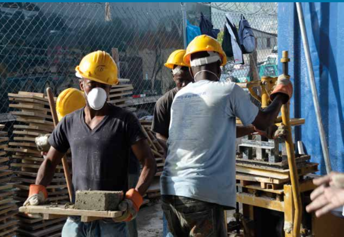
Travailleurs de la construction aidant à reconstruire Haïti après le séisme.
