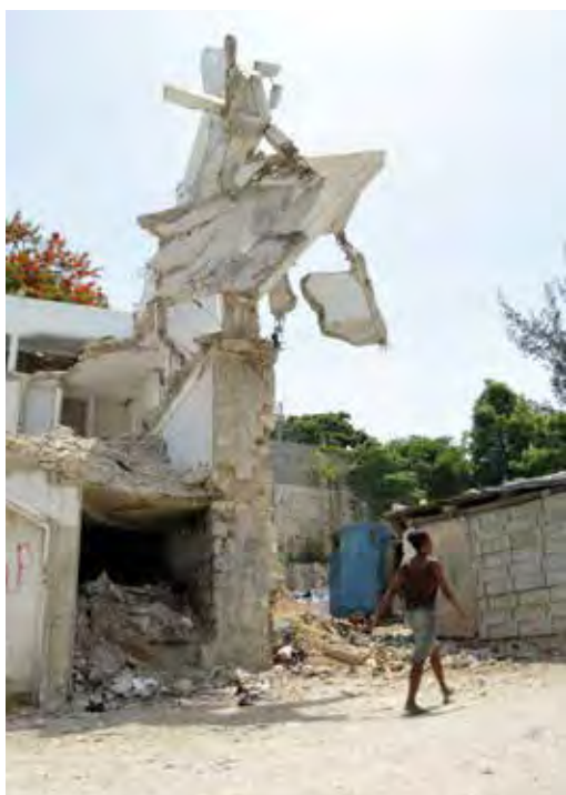
Des habitations de Port-au-Prince ravagées par le séisme.
