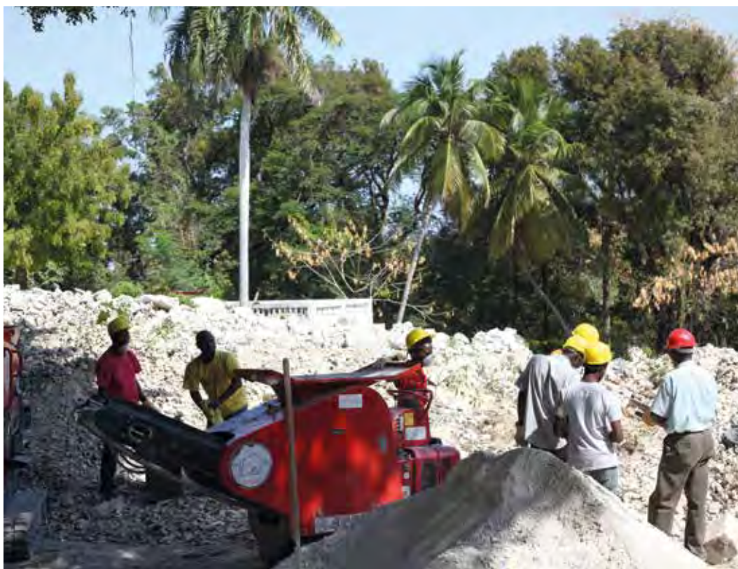
Un concasseur à moteur de taille moyenne sur le site de Turgeau.
