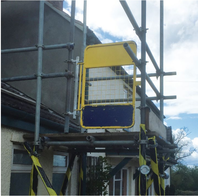
Figura 13. Poartă cu închidere automată la un punct de acces la schele.
