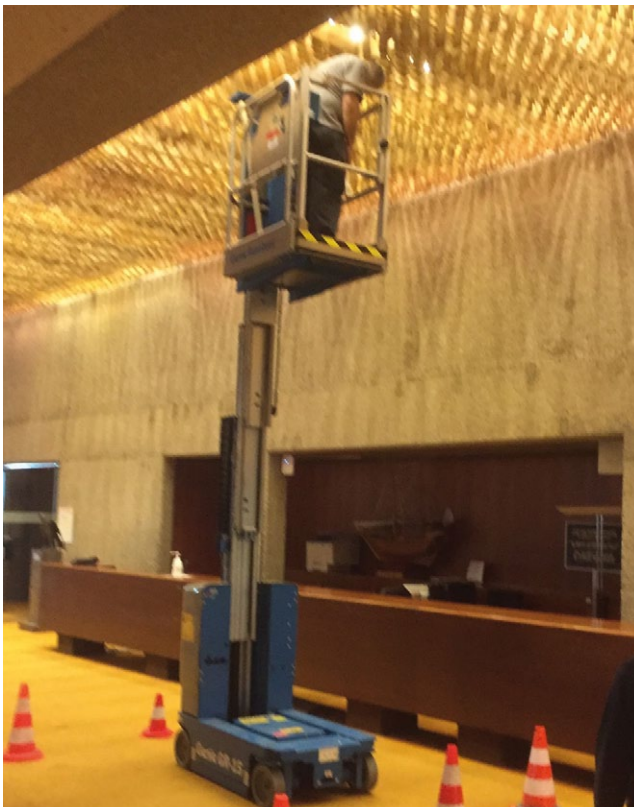
Figura 18. Platformă mobilă de lucru ridicată folosită într-un birou pentru schimbarea corpurilor de iluminat.
