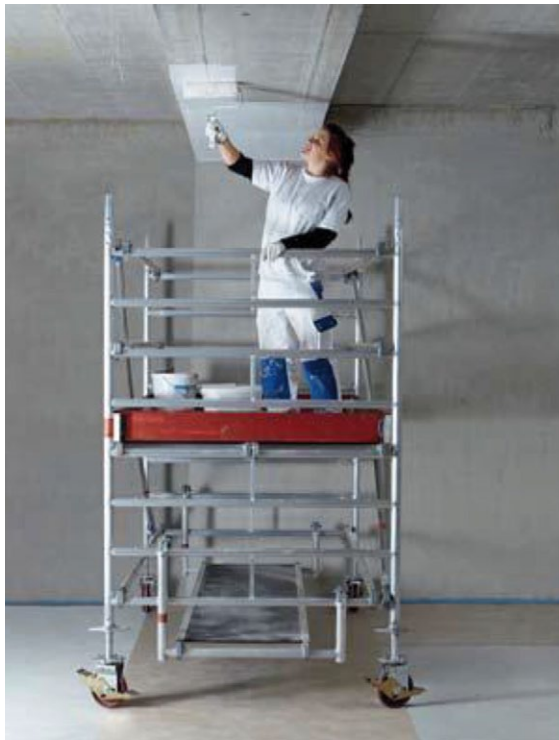
Figura 16. Schelă mobilă montată corect și aflată în uz.
