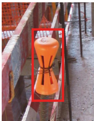
Figura 6. Tije de armare protejate, riscul de înjunghiere este controlat.
